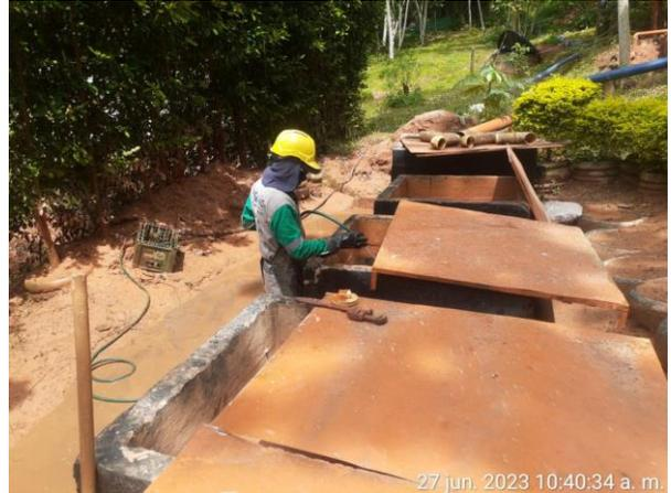
**Fotografía 34: Purga de tanques del sistema de tratamiento**
