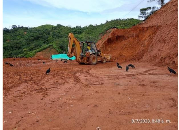
**Fotografía 34: Extracción material de cobertura**
