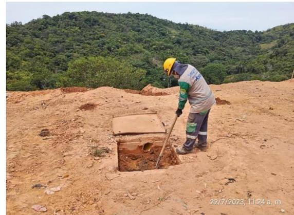
**Fotografía 36: Mantenimiento de caja de aguas lluvias**
