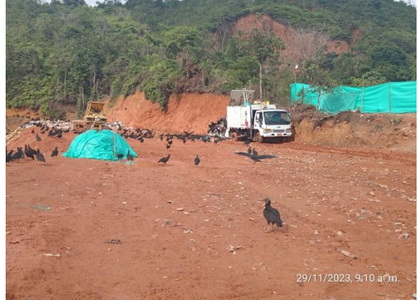
Fotografía 26: Descargue Relleno Sanitario
