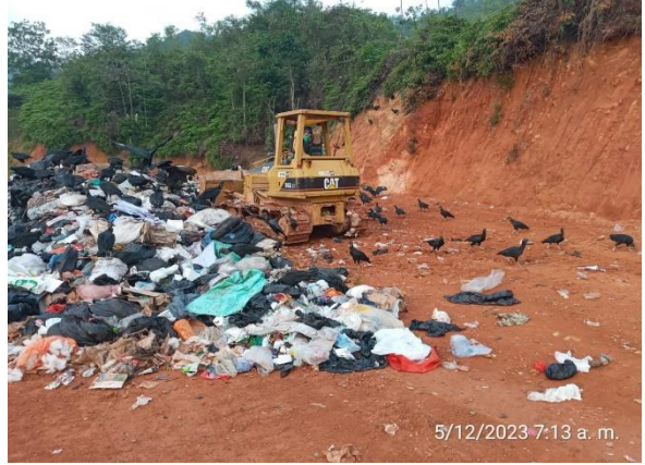
Fotografía 24: Descargue Relleno Sanitario
