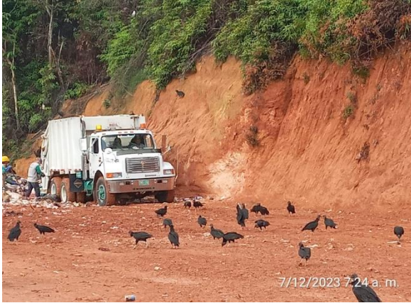
Fotografía 23: Descargue Relleno Sanitario
