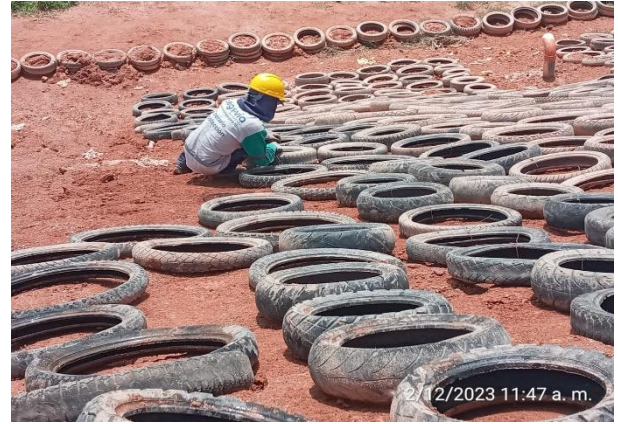
Fotografía 32: Amarre de llantas en talud
