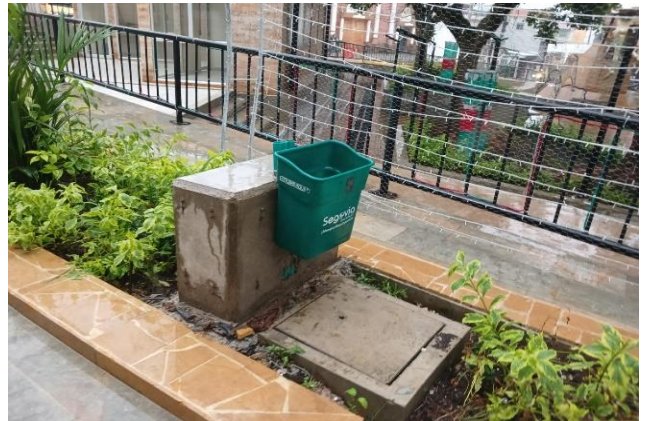
Fotografía 52: Instalación de canastillas
