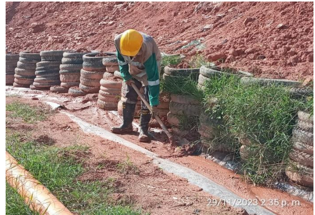
Fotografía 34: Limpieza de zanjas
