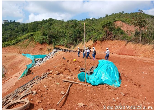
Fotografía 50: Visita al relleno UdeA
