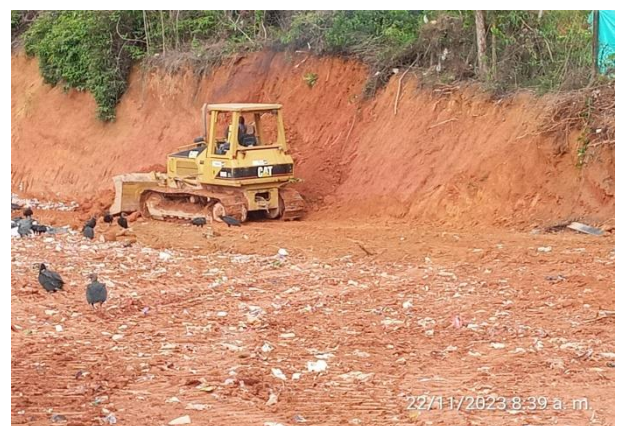
Fotografía 36: Cobertura de residuos sólidos
