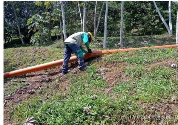
**Fotografía 32: Mantenimiento tubería de lixiviado**
