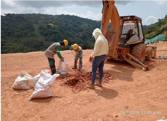
**Fotografía 29: Toma de medidas para calcular densidad de compactación**
