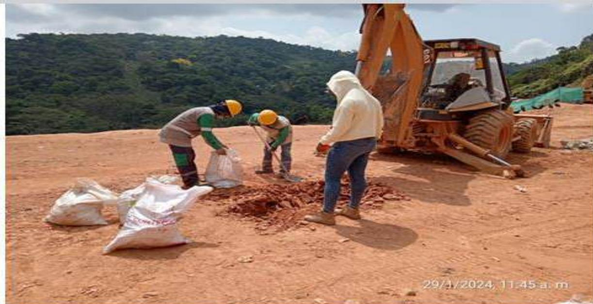
**Fotografía 29: Toma de medidas para calcular densidad de compactación**
