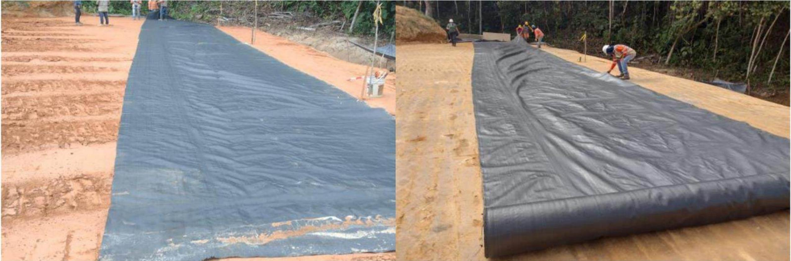
*Ilustración 8 instalación de geotextil TR3000*
