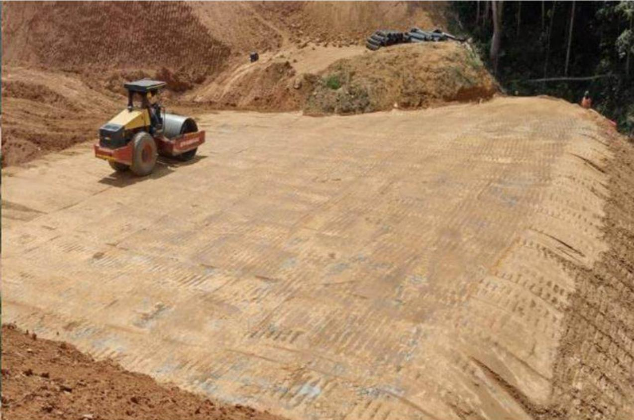
*Ilustración 3 Muro en tierra armada*
