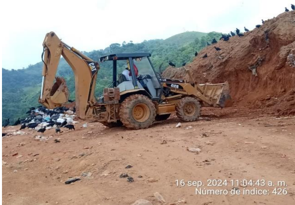
Foto N° 21: Retiro de Material de cobertura
