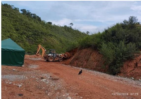
**Foto N° 30:** Extracción material de cobertura
