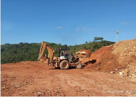
**Foto N° 28:** Extracción material de cobertura
