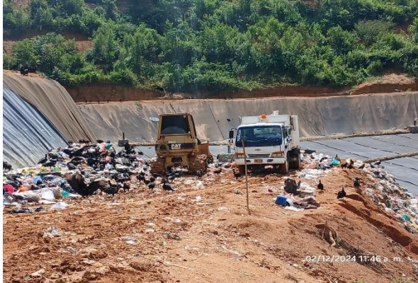
Foto N° 19: Descargue de residuos
