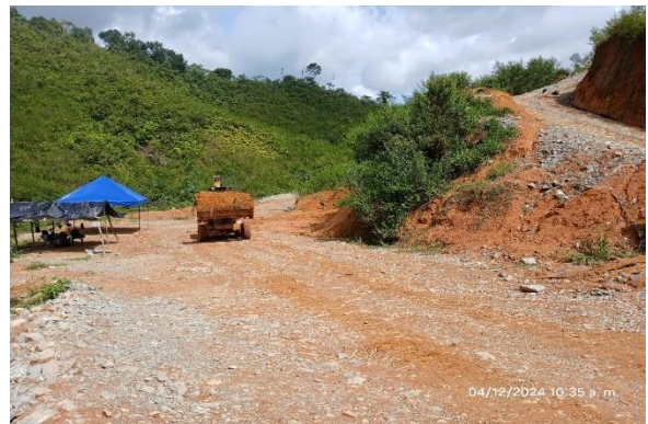
Foto N° 26: Traslado de material de cobertura
