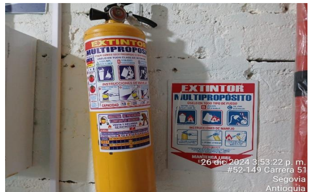
Foto N° 60: Inspección de extintor bodega de barrido
