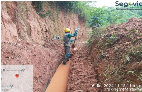
Foto N° 51: Inspección EPP supernumerarios relleno sanitario
