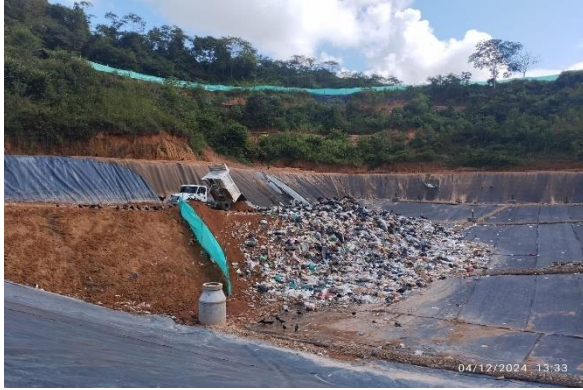
Foto N° 23: Cobertura de residuos sólidos
