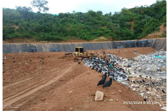
Foto N° 24: Cobertura de residuos sólidos
