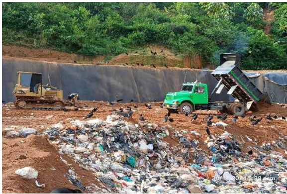
Foto N° 25: Cobertura de residuos sólidos
