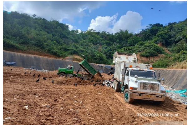
Foto N° 22: Descargue de residuos
