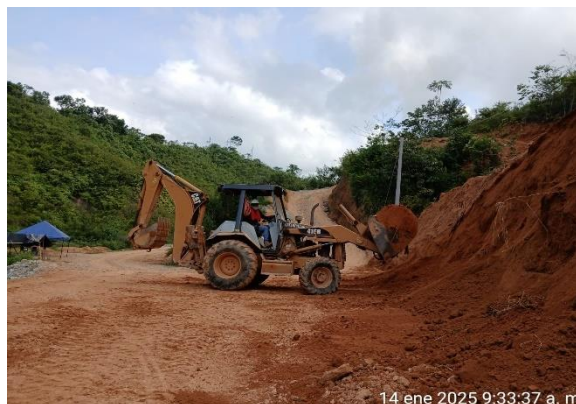
Foto N° 26: Traslado de material de cobertura
