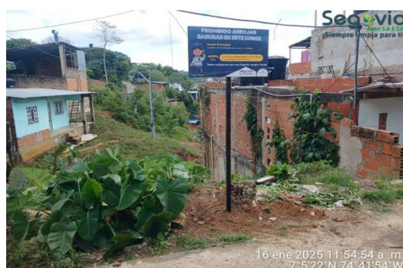
Foto N° 31: Instalación de valla El Establo
