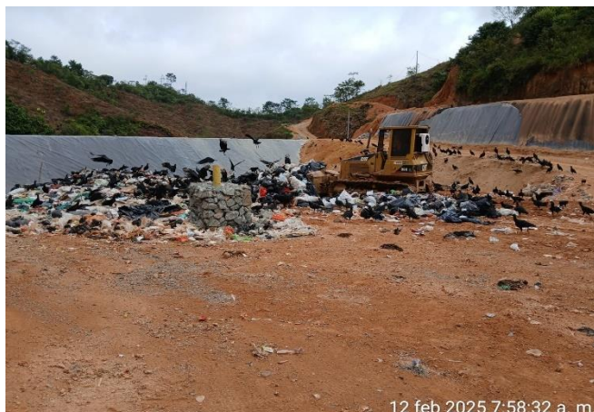
Foto N° 27: Cobertura de residuos sólidos
