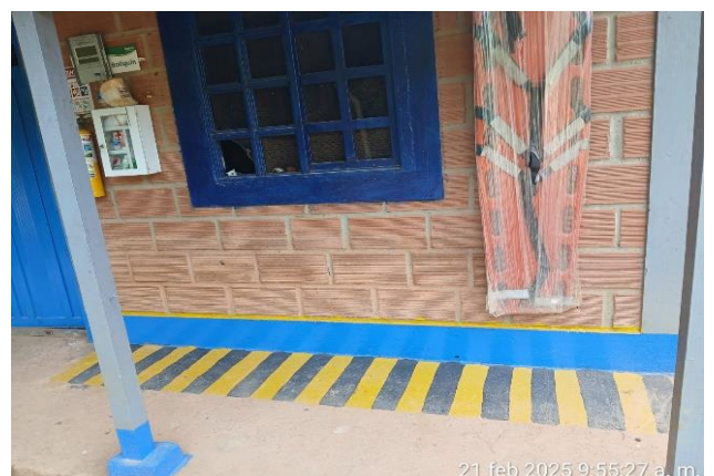
Foto N° 56: Inspección orden y aseo caseta de operaciones relleno sanitario
