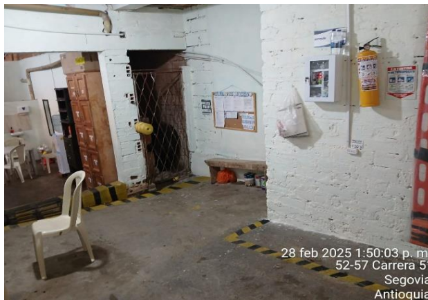
Foto N° 59: Inspección orden y aseo bodega de barrido
