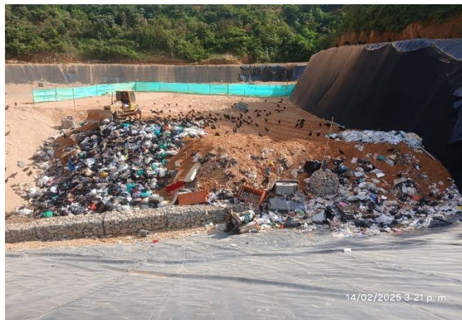
Foto N° 28: Cobertura de residuos sólidos
