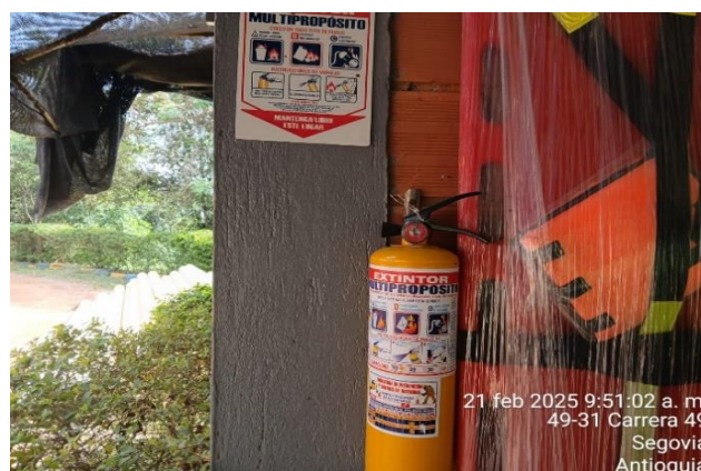
Foto N° 64: Inspección de extintor báscula
