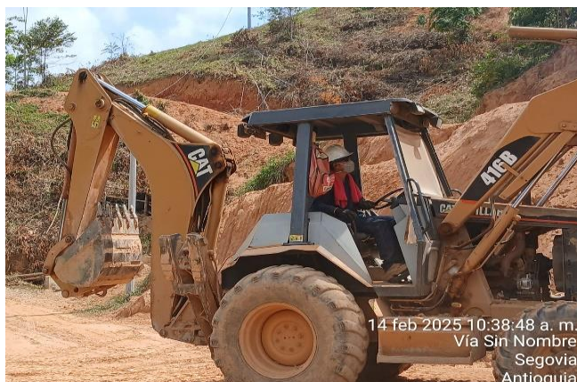
Foto N° 47: Inspección EPP relleno sanitario
