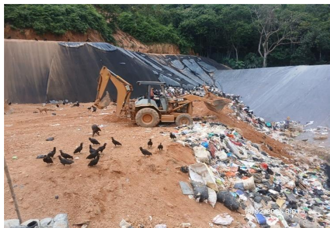
Foto N° 29: Cobertura de residuos sólidos
