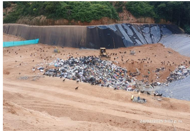
Foto N° 30: Cobertura de residuos sólidos
