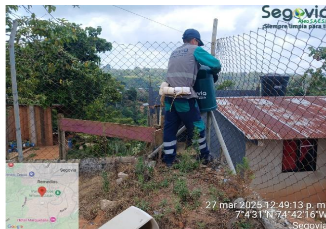
Foto N° 37: Instalación de canastilla galán sector el Gancho
