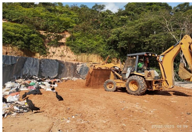
Foto N° 27: Cobertura de residuos sólidos
