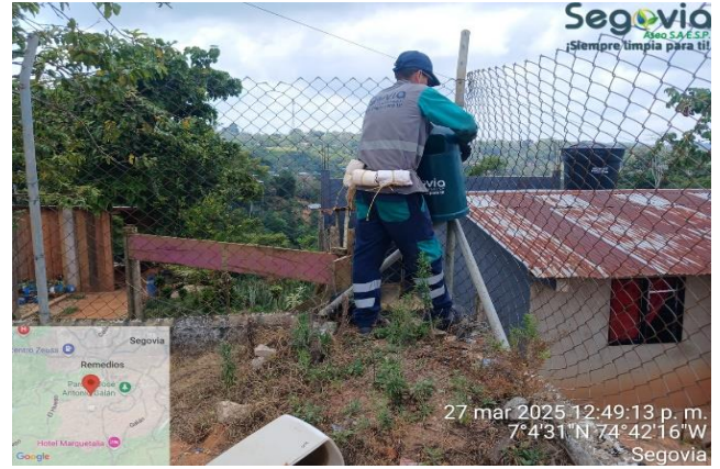
Foto N° 20: Instalación de canastilla
