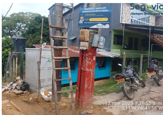
Foto N° 32: Instalación de valla
