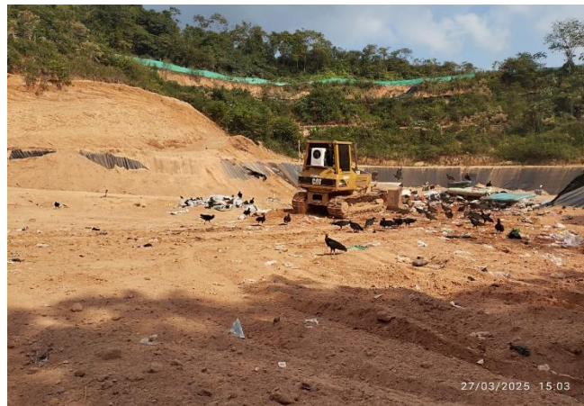
Foto N° 29: Cobertura de residuos sólidos
