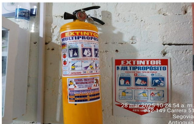
Foto N° 73: Inspección extintor bodega de barrido
