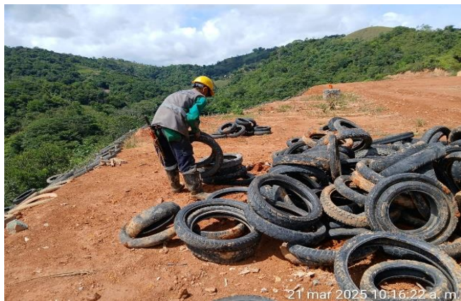
Foto N° 55: Inspección EPP relleno sanitario
