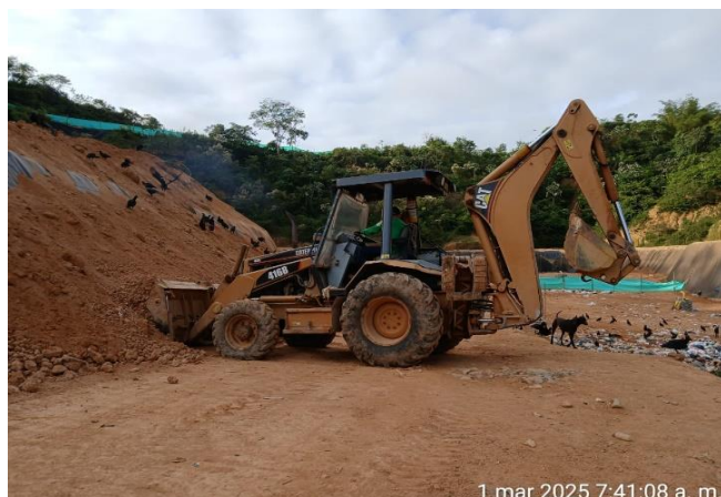
Foto N° 26: Remoción material de cobertura
