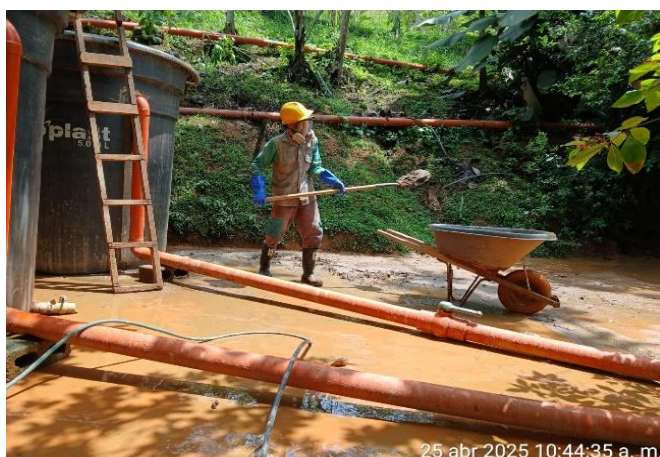
Foto N° 43: Inspección de EPP supernumerarios relleno sanitario
