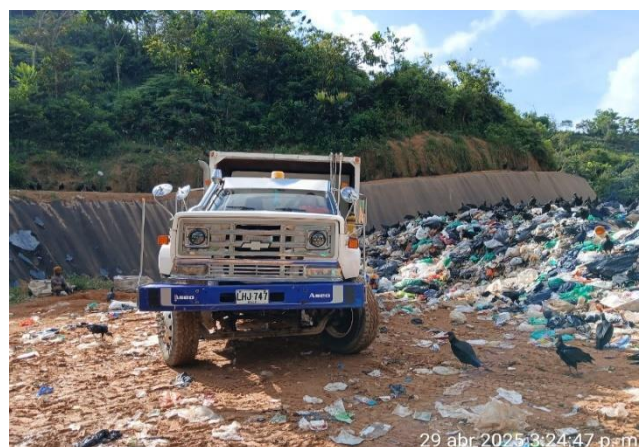
Foto N° 25: Descargue de residuos
