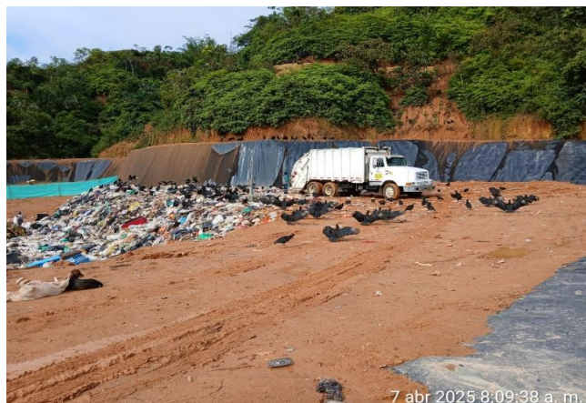
Foto N° 22: Descargue de residuos
