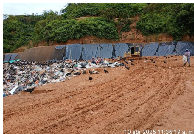
Foto N° 27: Cobertura de residuos sólidos
