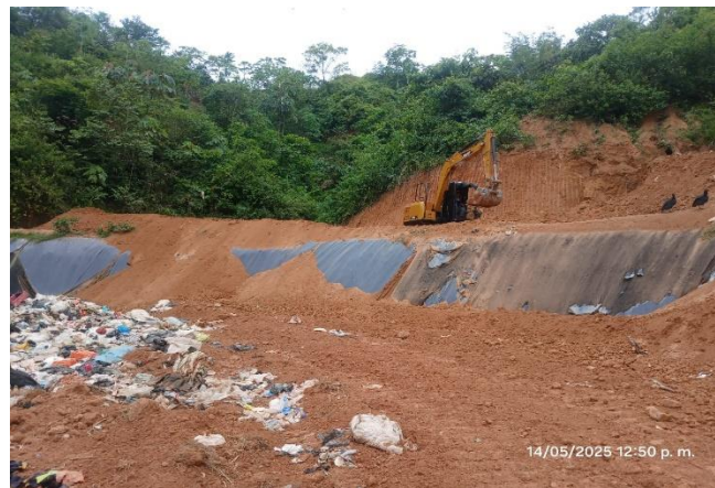
Foto N° 38: Cobertura de residuos sólidos
