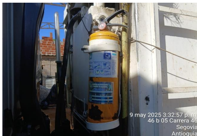
Foto N° 76: Inspección elementos de emergencia oficina administrativa
