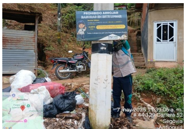
Foto N° 43: Instalación de vallas
