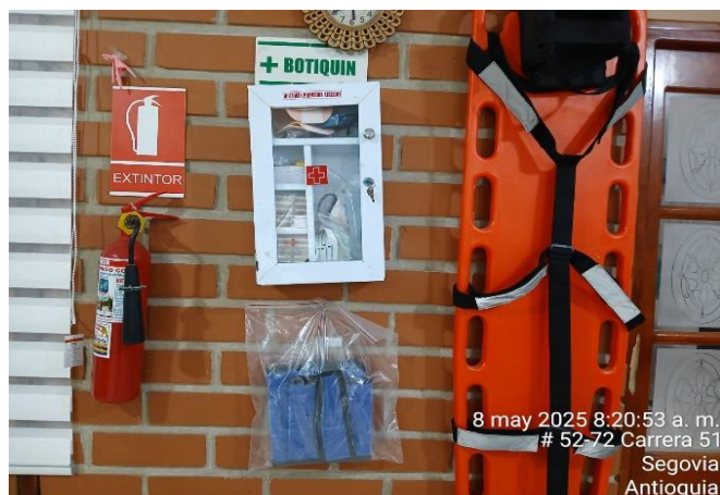
Foto N° 75: Inspección elementos de emergencia oficina administrativa
