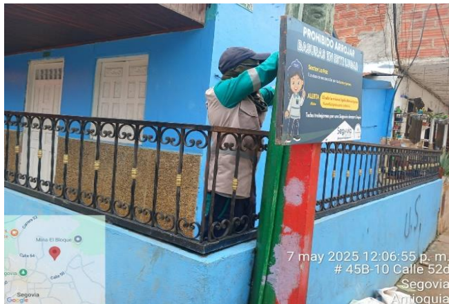
Foto N° 27: Instalación de valla Reversadero la Paz
