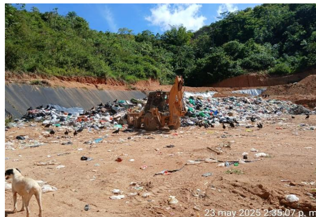
Foto N° 40: Cobertura de residuos solidos
