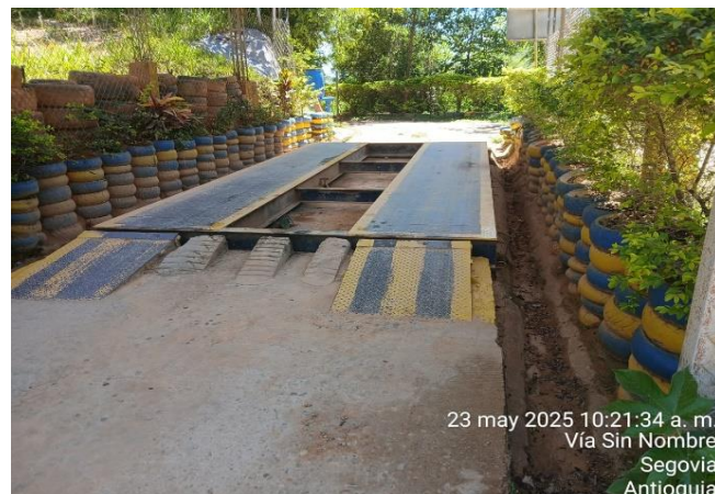
Foto N° 86: Inspección orden y aseo relleno sanitario
