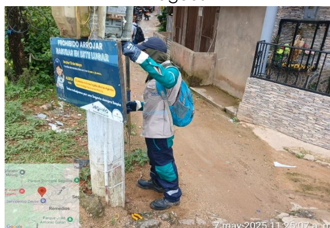
Foto N° 26: Instalación de valla 13 de mayo
