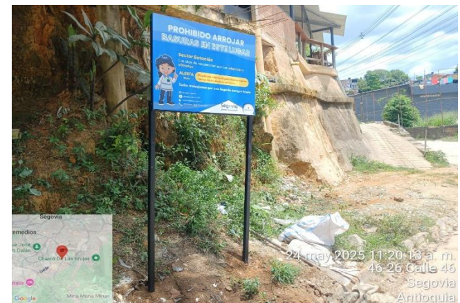
Foto N° 30: Instalación de valla Bataclan
