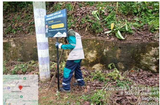
Foto N° 28: Instalación de valla Urbanización el Tigrito
