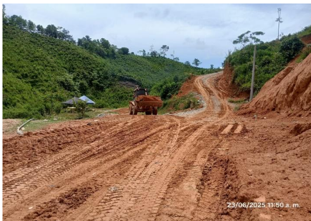
Foto N° 28: Remoción de material para cobertura
