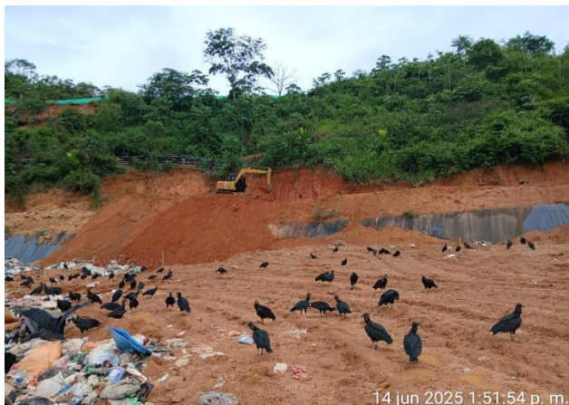
Foto N° 26: Cobertura de residuos sólidos
