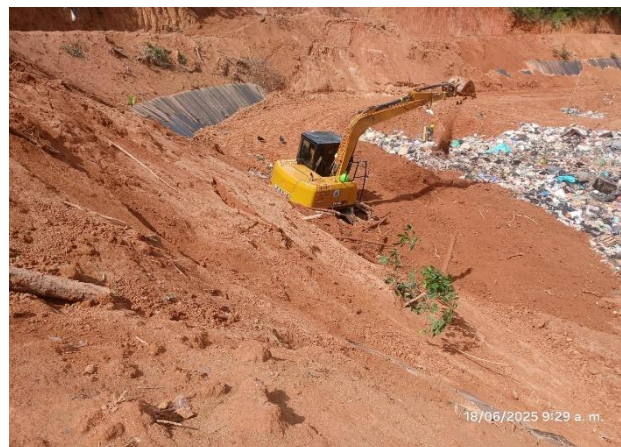
Foto N° 27: Cobertura de residuos sólidos
