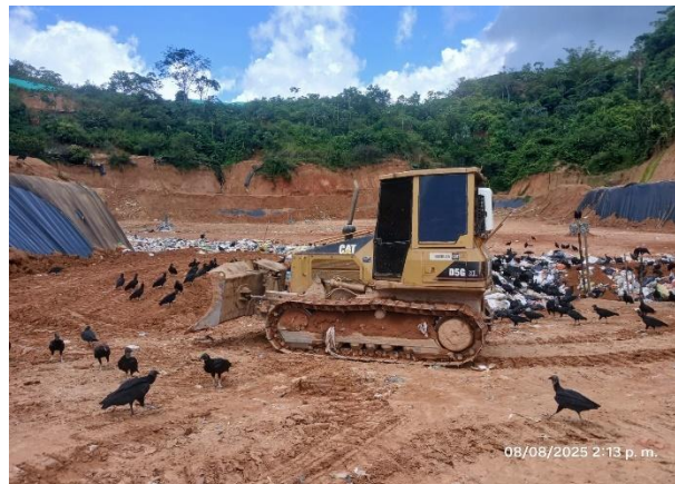
Foto N° 27: Cobertura de residuos sólidos
