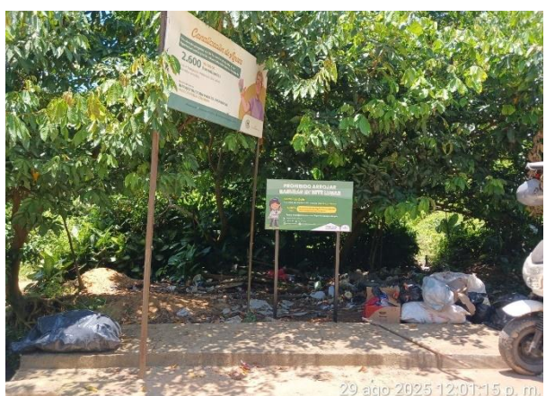
Foto N° 40: Instalación de valla en la Guía
