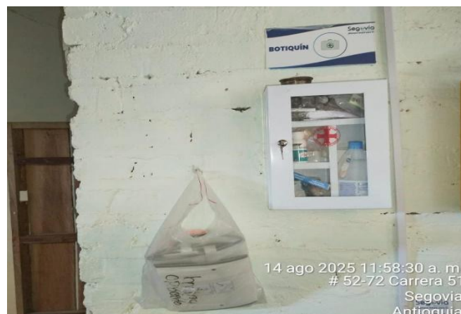
Foto N° 60: Inspección botiquín bodega operativa
