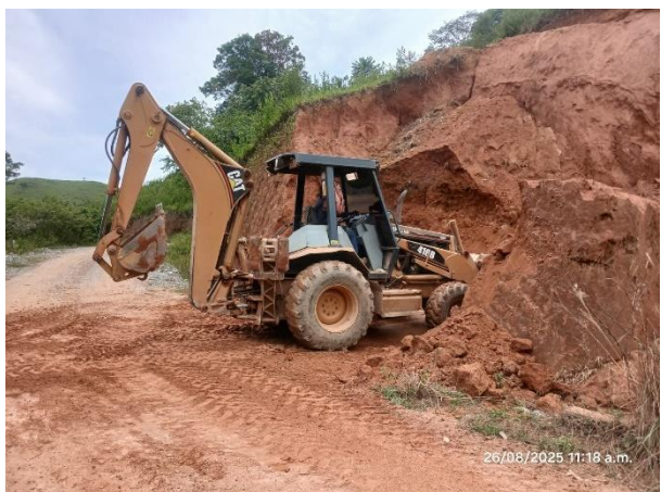
Foto N° 28: Remoción de material para cobertura
