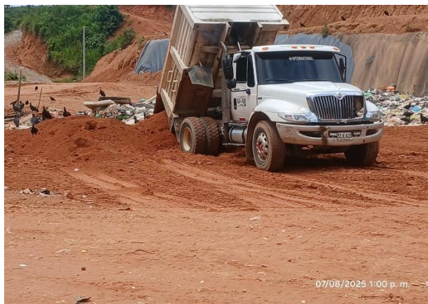
Foto N° 26: Descargue de material de cobertura
