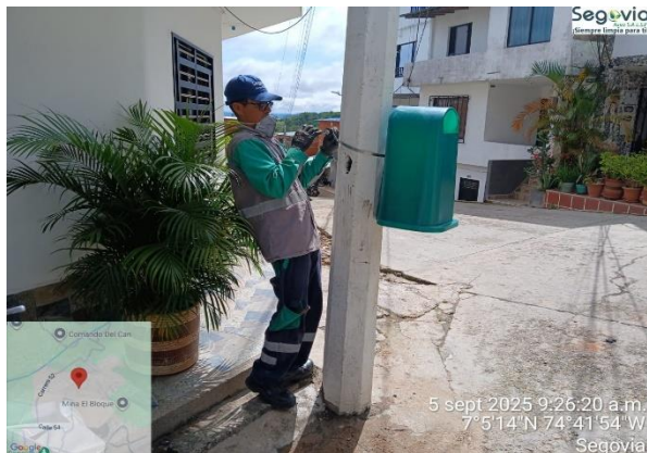
Foto N° 27: Instalación de canastillas San bartolo
