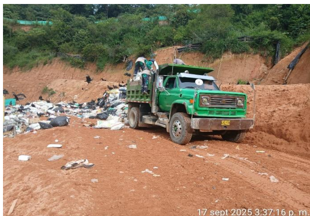
Foto N° 31: Descargue de residuos
