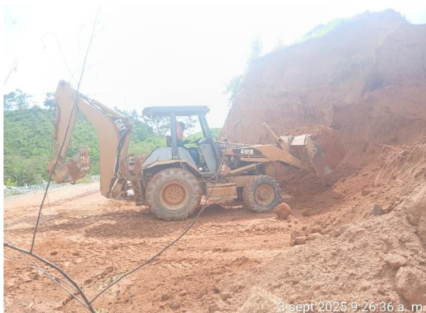
Foto N° 35: Remoción de material para cobertura
