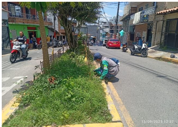
Foto N° 19: Corte de césped Separadores de Porro
