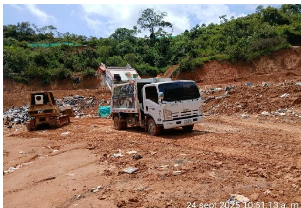
Foto N° 33: Descargue de residuos
