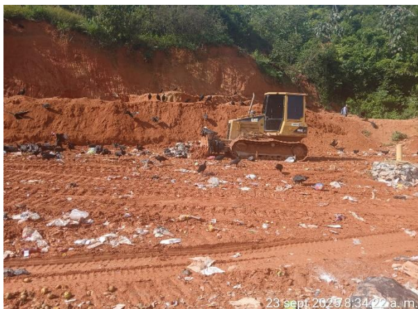
Foto N° 37: Cobertura de residuos sólidos
