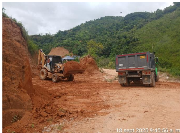
Foto N° 36: Cobertura de residuos sólidos
