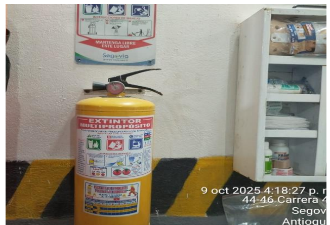
Foto N° 59: Inspección de extintor parque automotor #1
