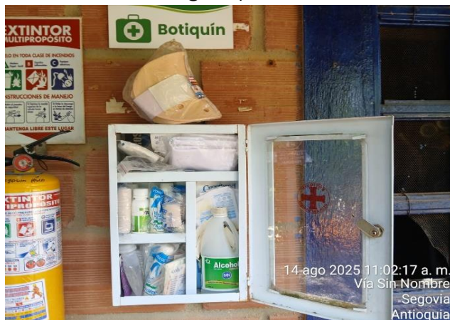
Foto N° 64: Inspección de botiquín caseta operaciones relleno sanitario
