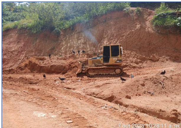
Foto N° 29: Remoción de material para cobertura
