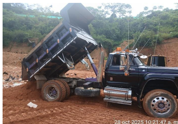
Foto N° 32: Descargue de material para cobertura
