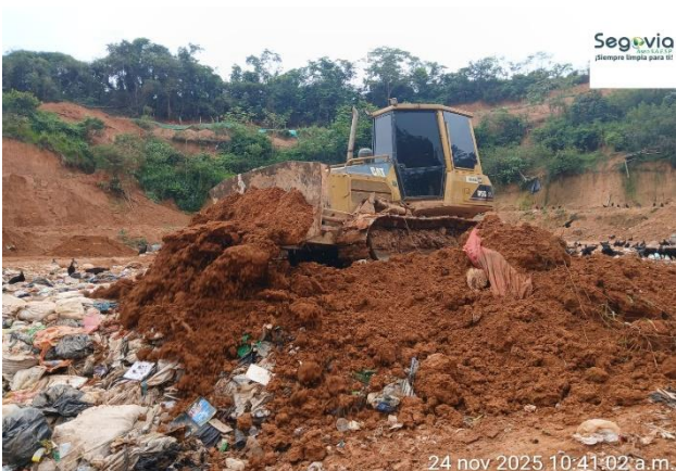
Foto N° 35: Cobertura de residuos sólidos
