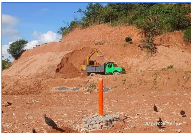
Foto N° 33: Remoción de material para cobertura
