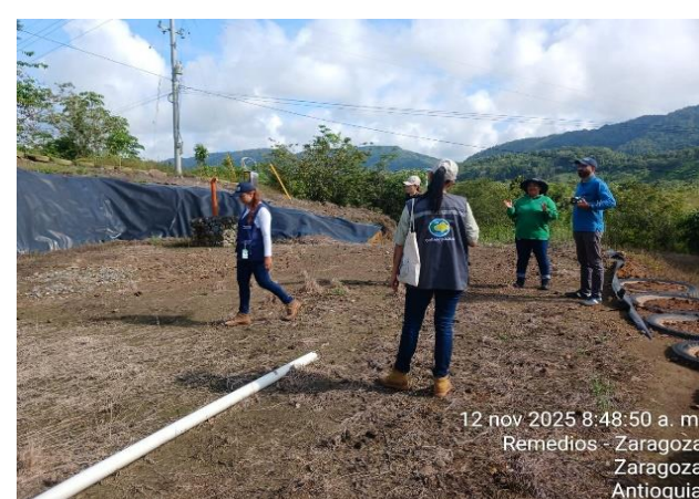
Foto N° 42: Visita Corantioquia relleno sanitario Fraguas
