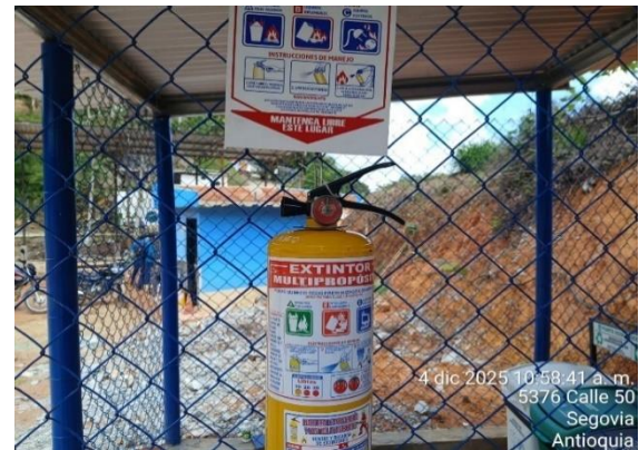
Foto N° 73: Inspección extintor planta de tratamiento lixiviado
