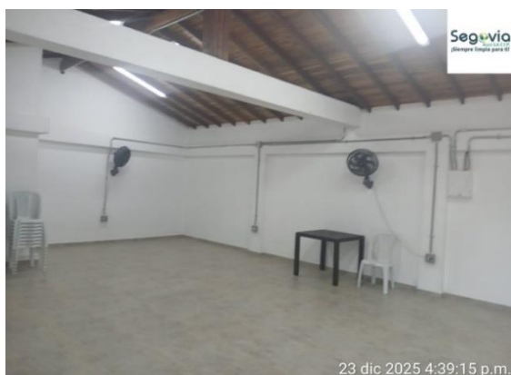
Foto N° 80: Inspección orden y aseo relleno sanitario Vera 2
