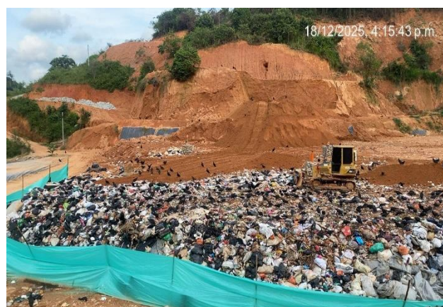
Foto N° 40: Cobertura de residuos sólidos
