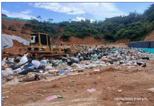
Foto N° 35: Empuje de residuos solidos
