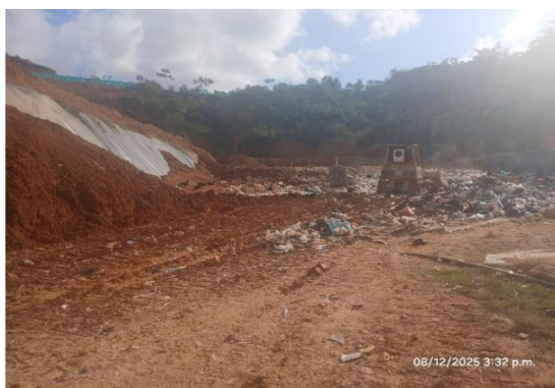
Foto N° 37: Empuje de residuos solidos
