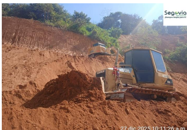
Foto N° 39: Remoción de material para cobertura
