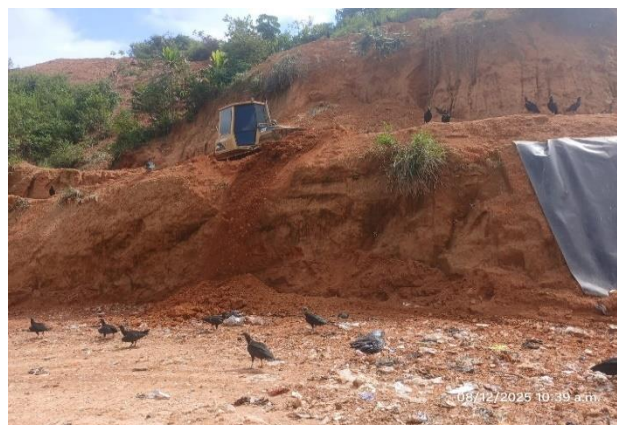
Foto N° 36: Remoción de material para cobertura
